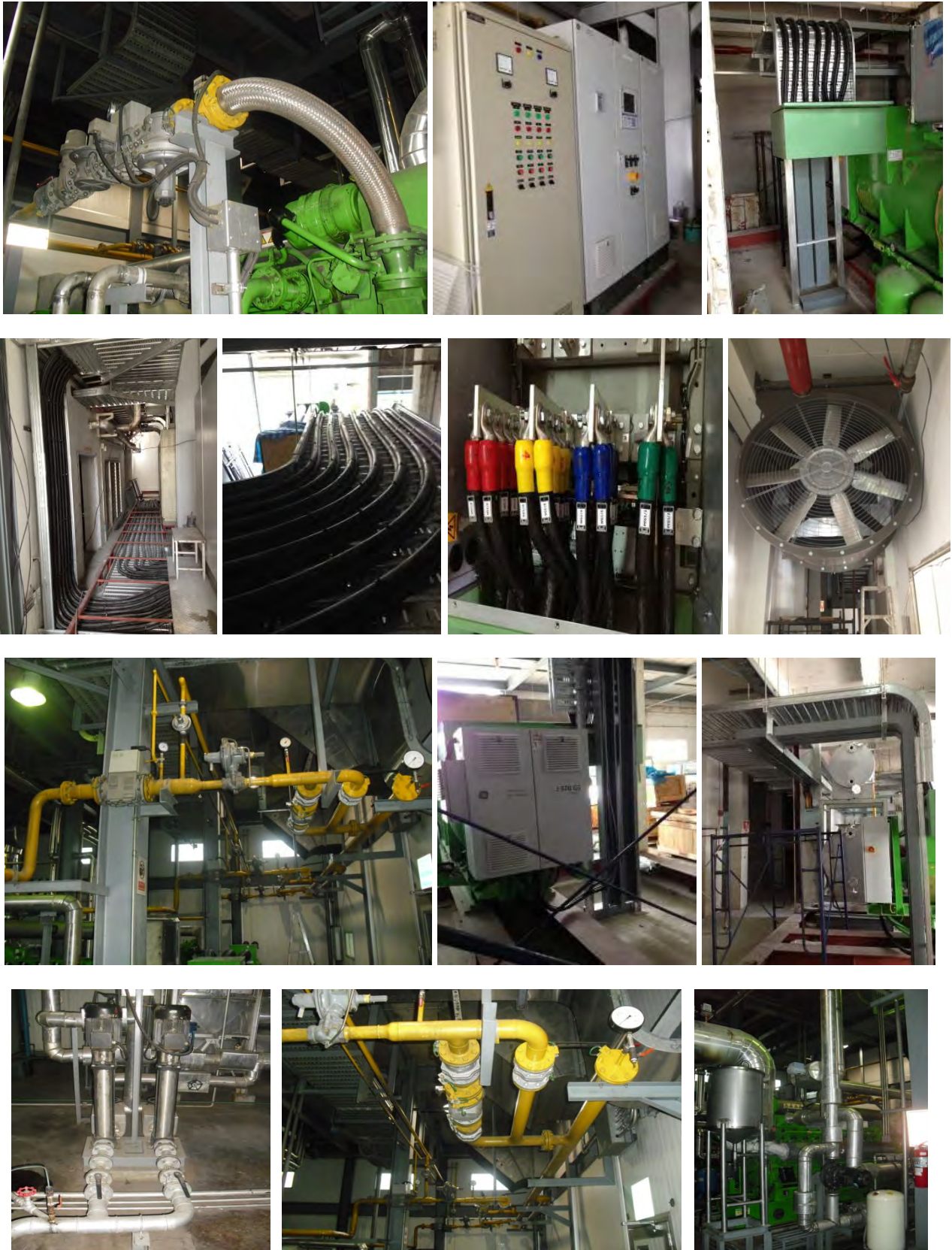
รูปภาพการติดตั้งและWiring สาย Main Power Main Power เข้าที่ Terminal Alternator/ห้อง Gas Engine
